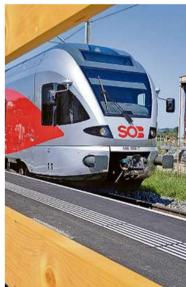
Eine grosse Baustelle: Der Joner Bahnhof Blumenau wird behindertengerecht umgebaut – und bekommt schon bald einen Halbstundentakt.
