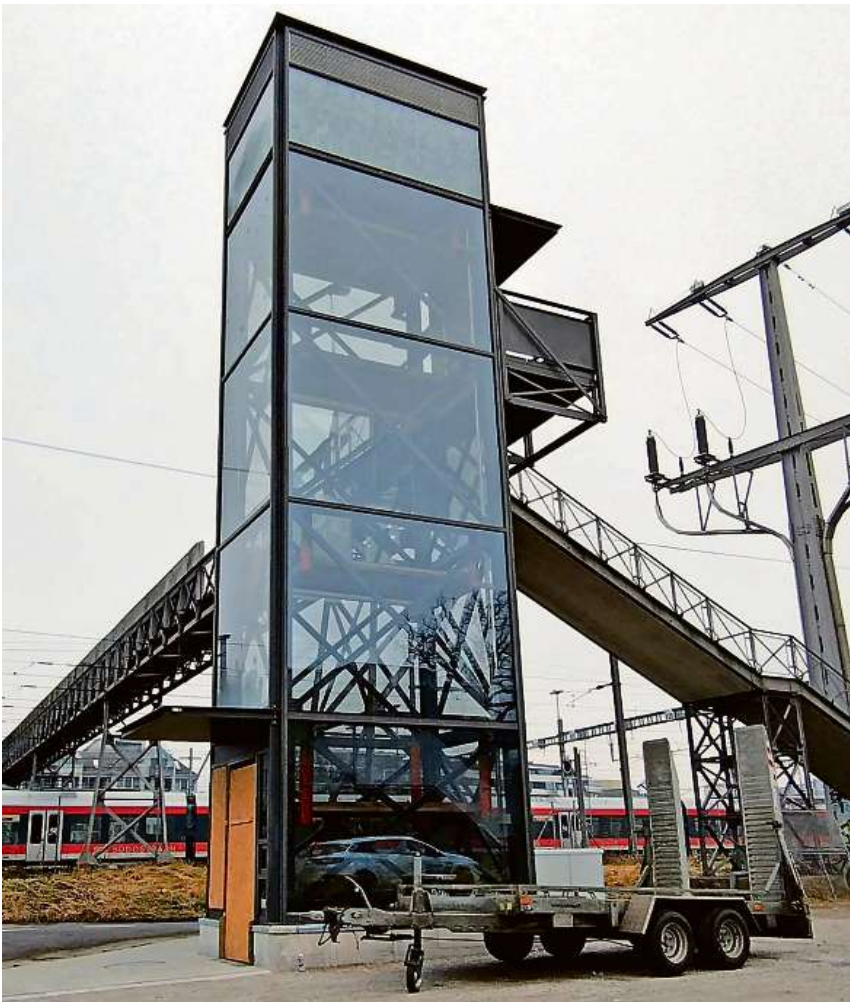
Montiert und installiert: Der südliche Liftturm ist wie sein Gegenüber auf der anderen Seite der Passerelle fertig – aber noch nicht betriebsfähig.
